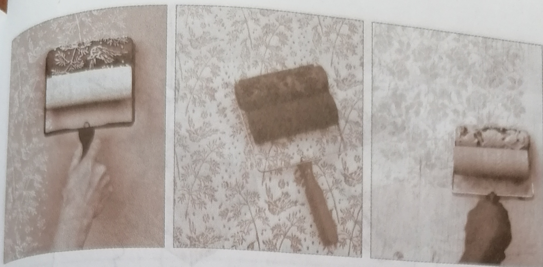
рис. 5.6. Накатка узорными валиками
